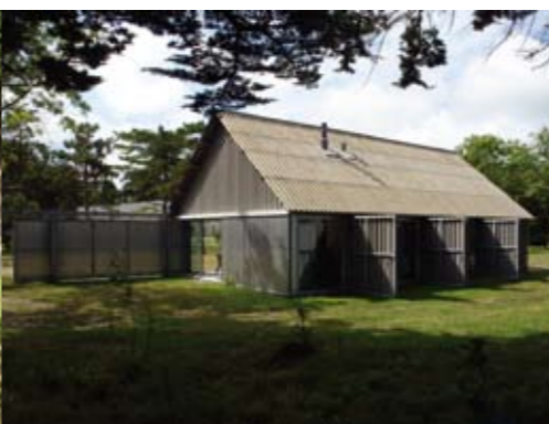
La maison de l'est : tous usages (78 m 2 ). Toits et murs transparents, sol en sable.
