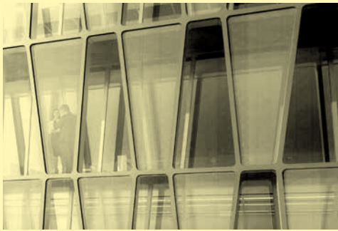
XTU, capteur solaire biologique à base de microalgues, prototype de biofaçade.
