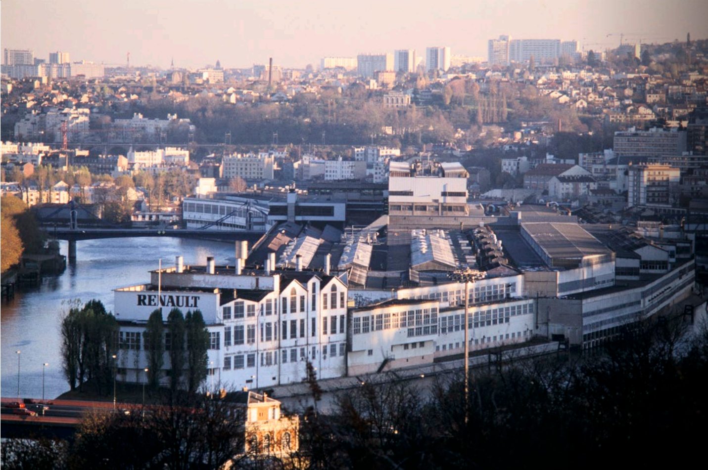
L'usine historique de Renault-Billancourt sur l'île Seguin à Boulogne-Billancourt, reconstruite par Albert Laprade
